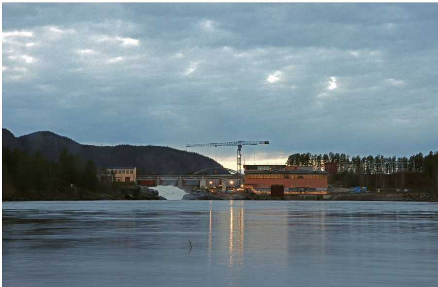
Hammarforsen i Indalsälven. Alla större vattendrag i distriktet är utbyggda för vattenkraft. Foto: vattenmyndigheten
